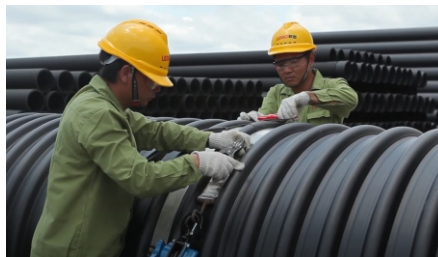
5. Pemasangan Mesin Electro Fusion
