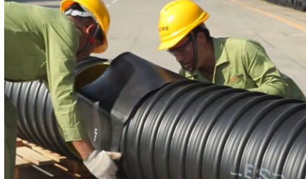
2. Pemeriksaan Kondisi Pipa dan Accessories
