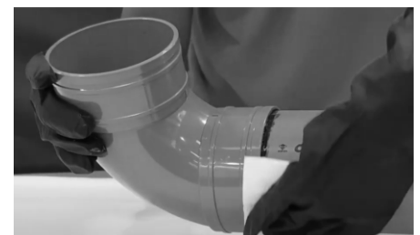
6. Pemasangan pipa dan fitting
