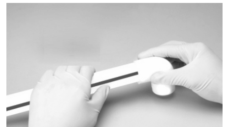
6. Pemasangan pipa dan fitting
