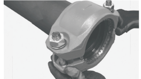
3. Pemasangan Coupling
