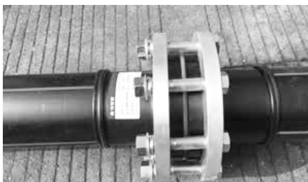
4. Pemasangan Baut & Mur
