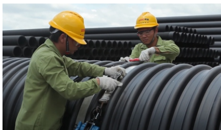
5. Pemasangan Mesin Electro Fusion
