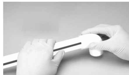
6. Pemasangan pipa dan fitting
