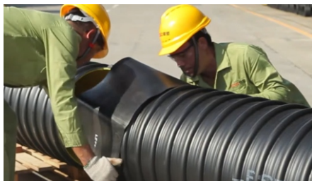
2. Pemeriksaan Kondisi Pipa dan Accessories
