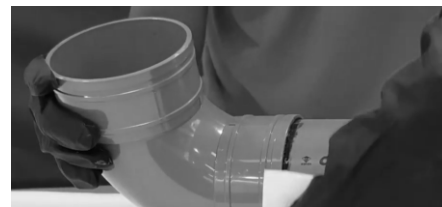
6. Pemasangan pipa dan fitting
