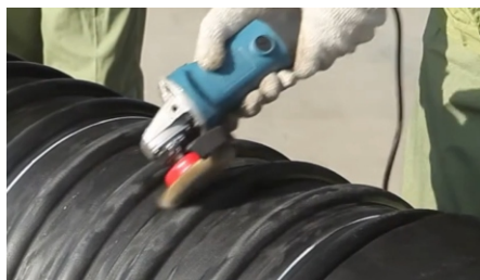
4. Persiapan Permukaan Sambungan
