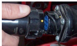
Sambungkan kabel dengan box kelistrikan
