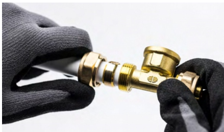
4. Perakitan Komponen Fitting
