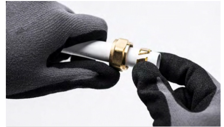
3. Pemasangan pipa ke dalam fitting
