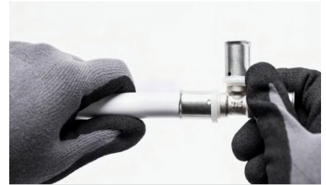
3. Pemasangan pipa ke dalam fitting
